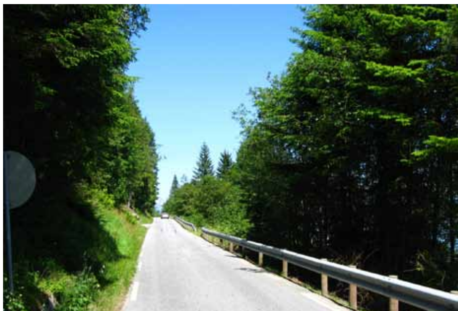
Grønn tunnel med gran i Vik, utsikt mot nord Vikøyri, Vik, Sogn og Fjordane. Foto: Anders Bryn
